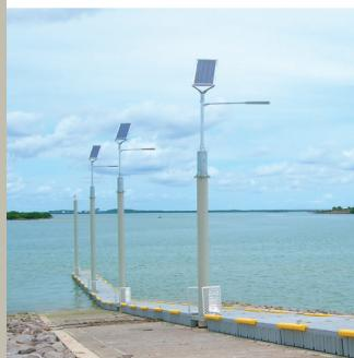
Εξασφαλίζουν οικονομικότερο φωτισμό με ελάχιστες έως μηδενικές εργασίες συντήρησης σε χώρους όπως στάθμευσης αυτοκινήτων, λιμενοβραχίονες, εργοτάξια κ.λ.π.. Σημειώνεται ότι ο **χρόνος ζωής** των LED υπερβαίνει τις **20.000 ώρες** λειτουργίας. Ταυτόχρονα αποτελούν την ιδανικότερη λύση για περιοχές όπου η εγκατάσταση δικτύου ηλεκτρικού ρεύματος είτε δεν προβλέπεται, είτε είναι αδύνατη, είτε είναι οικονομικά ασύμφορη.
